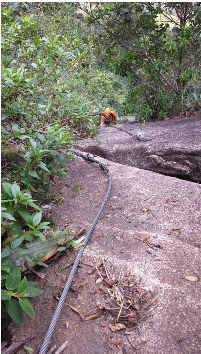
A avaliação e medição do Trecho a partir da bifurcação que leva a via de escalada Leste não estão nesse documento, mas também possui cabos, cordas e grampos bastante deteriorados, que necessitam ser substituídos.
