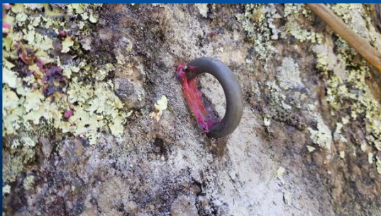
Instalação de Tensor de Titânio
