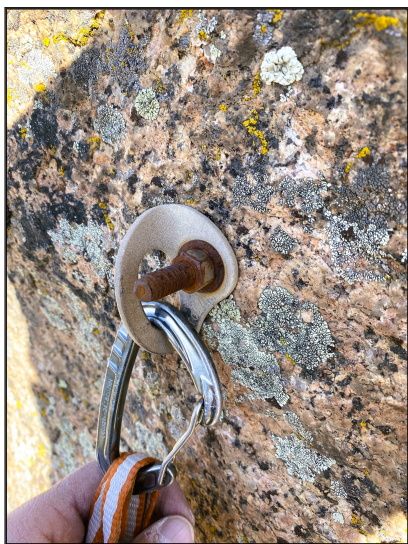
Figura 2: Ilustração de uma ancoragem fixa em péssimo estado. Fonte: Boulder Climbing Community. How Do You Assess Bad Hardware While Climbing? . Disponível em: Assessing Bad Hardware While Climbing; the Do's . Acesso em: 08 de out. de 2024.
