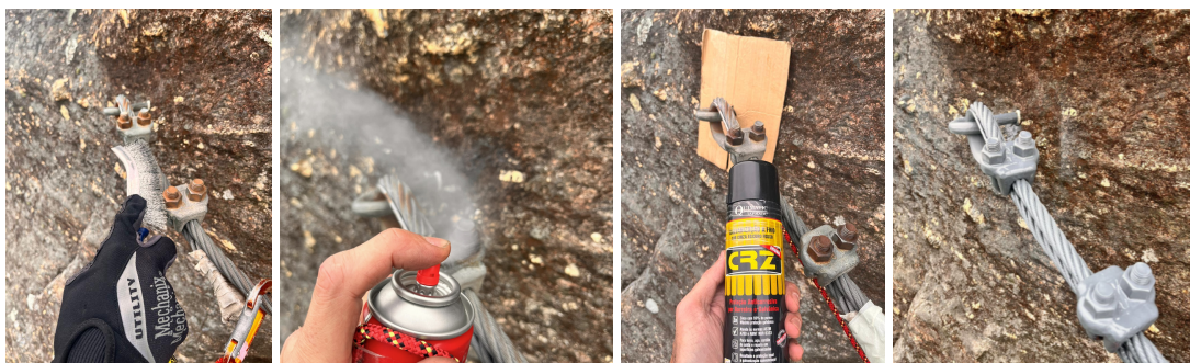
Figura 10 - Reposição de zinco a frio.
