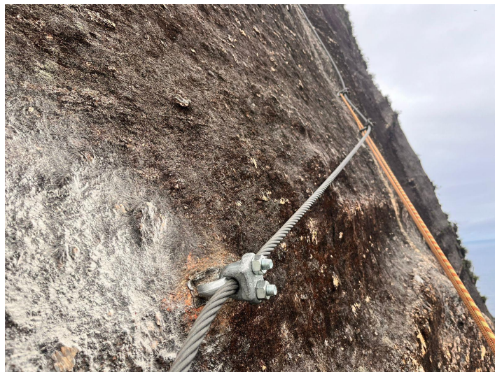
Figura 9 - Nova ancoragem no trecho horizontal inicial.
