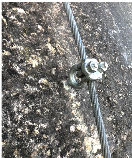
Figura 3 - Típica montagem do olhal como ancoragem do cabo de aço da via CEPI
