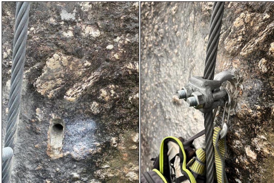
Figura 8 - À esquerda, a preparação do furo para embutimento. À direita, o olhal instalado. Fotos do dia reforma 09/07/2024.
