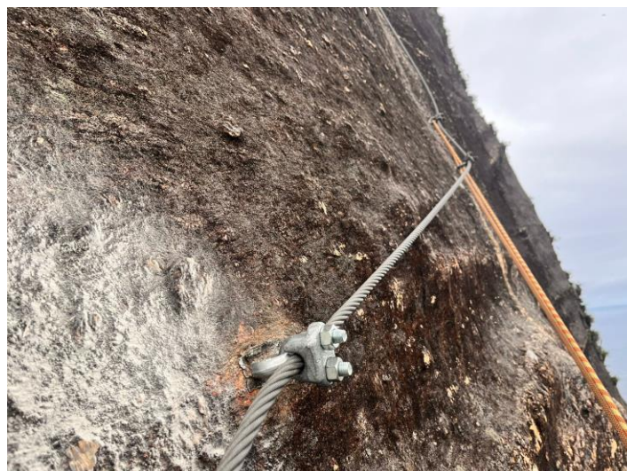
Figura 9 - Nova ancoragem no trecho horizontal inicial.
