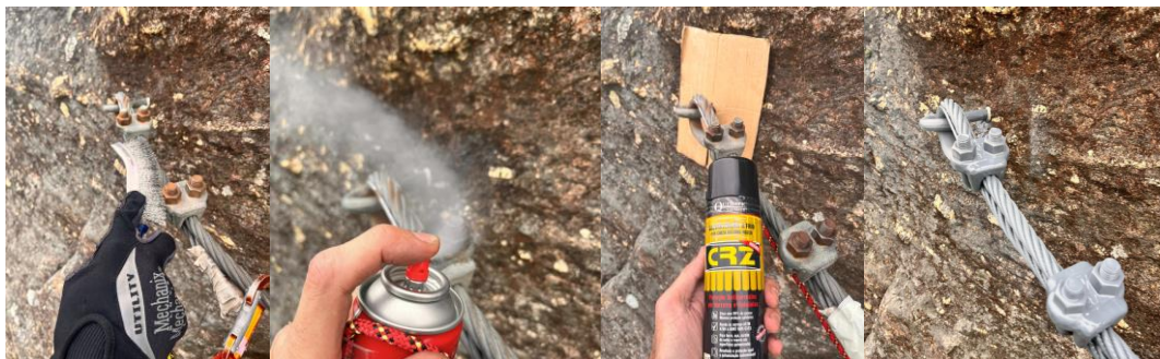
Figura 10 - Reposição de zinco a frio.
