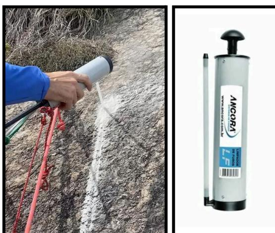
Figura 39: equipamentos para limpeza do furo.
