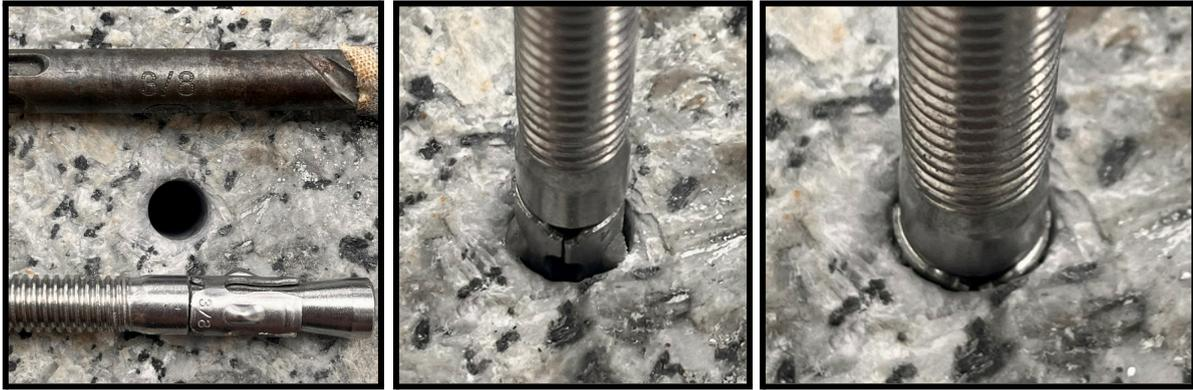
Figura 20: furo de 3/8" para chumbador de 3/8", inserção justa no furo, atenção com a acomodação da presilha durante o martelamento.
