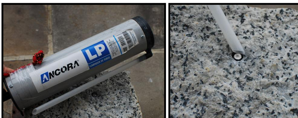
*Figura 56: expulsão de pó após limpeza.*
