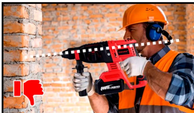
Figura 37: erro na empunhadura, risco de furo desviado.
