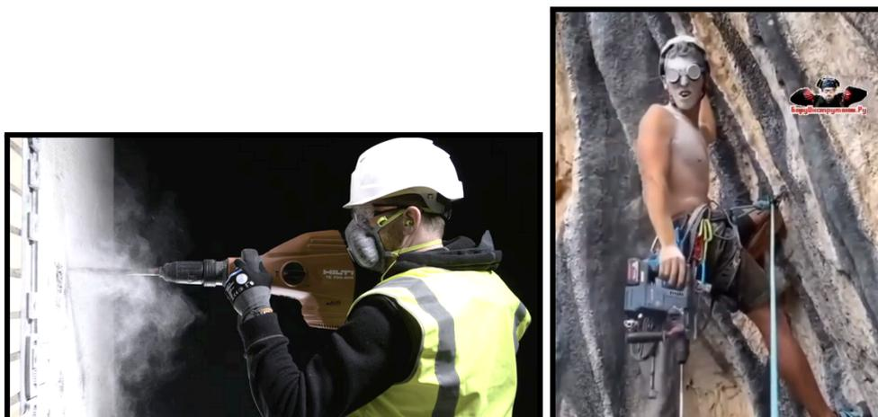
Figura 31: Esquerda: exemplo correto de uso em ambiente industrial, note o fundo escuro sob luz de flash para indicar como é grande a zona com poeira suspensa (Fonte: Hilti), ver [Risco de contaminação por poeira em obras](#). Direita: postagem em mídia social alertando para os risco da exposição a poeira da perfuração.
